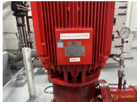
ภาพที่ 2.2-32 เครื่องสูบน้ำดับเพลิงแบบไฟฟ้า
