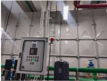
ภาพที่ 2.2-17 ระบบสูบน้ำในอาคาร/ถังสำรองน้ำในอาคาร
