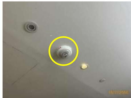
ภาพที่ 2.2-29 เครื่องตรวจจับความร้อน
