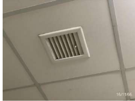
ภาพที่ 2.2-25 พัดลมดูดอากาศในห้องพักมูลฝอยเปียก
