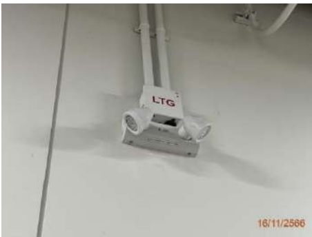
ภาพที่ 2.2-26 ระบบไฟฟ้าฉุกเฉิน
